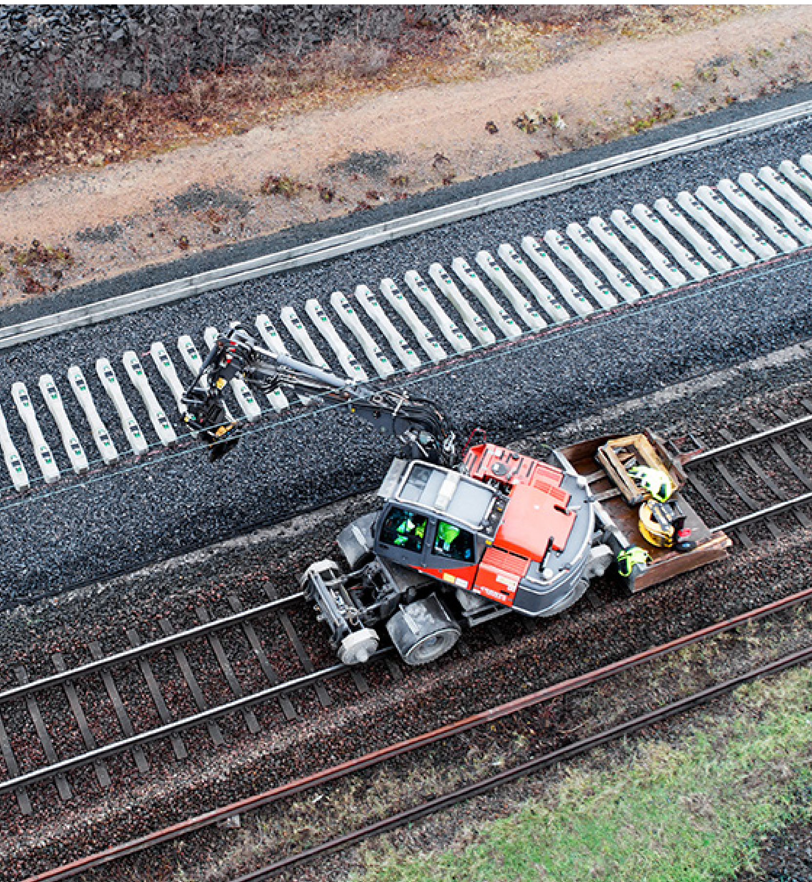
Spårbyggnad för dubbelspår, Kristianstad. Foto: Hasse Bengtsson
