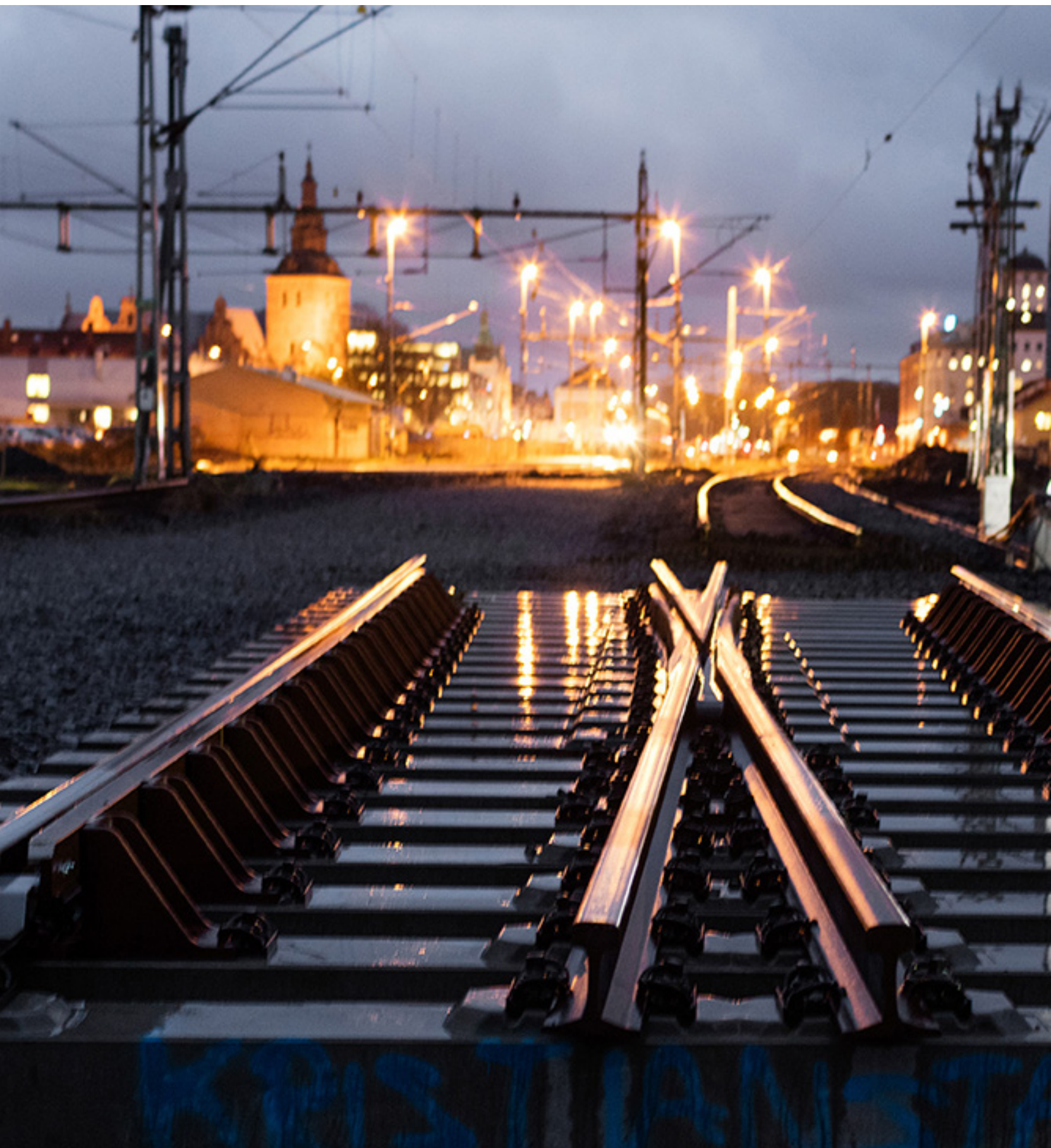
Växel i väntan på montering för dubbelspår, Kristianstad. Foto: Hasse Bengtsson
