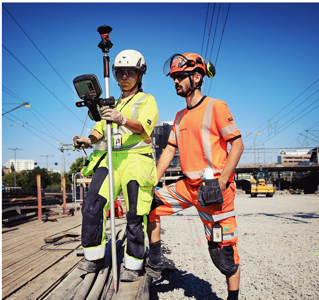
Inmätning av spårläge, Getingmidjan, Stockholm. Foto: Christian Nilsson
