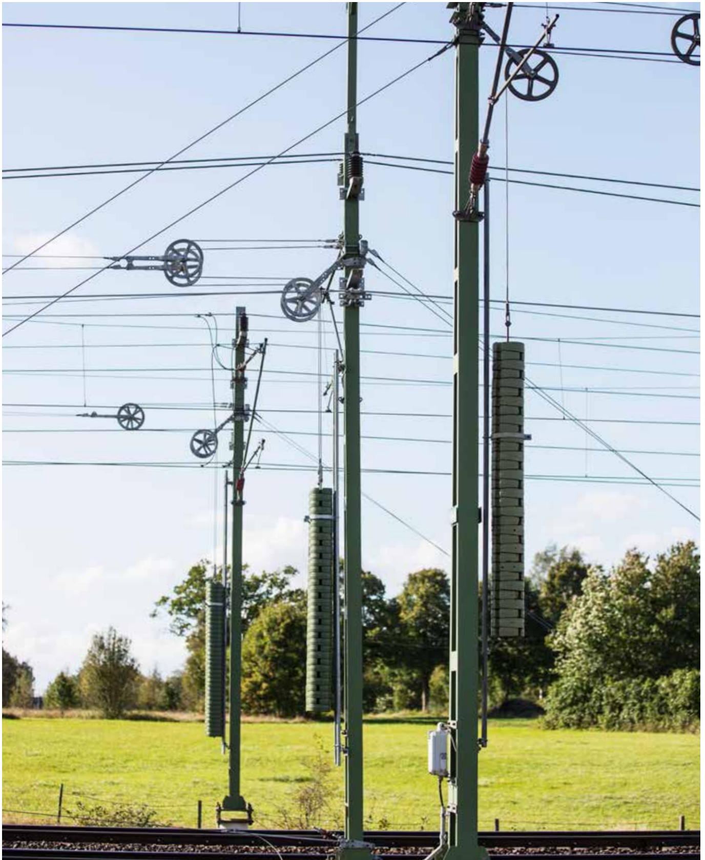
Kontaktledningsstolpar med monterade viktavspänningsatsar.
