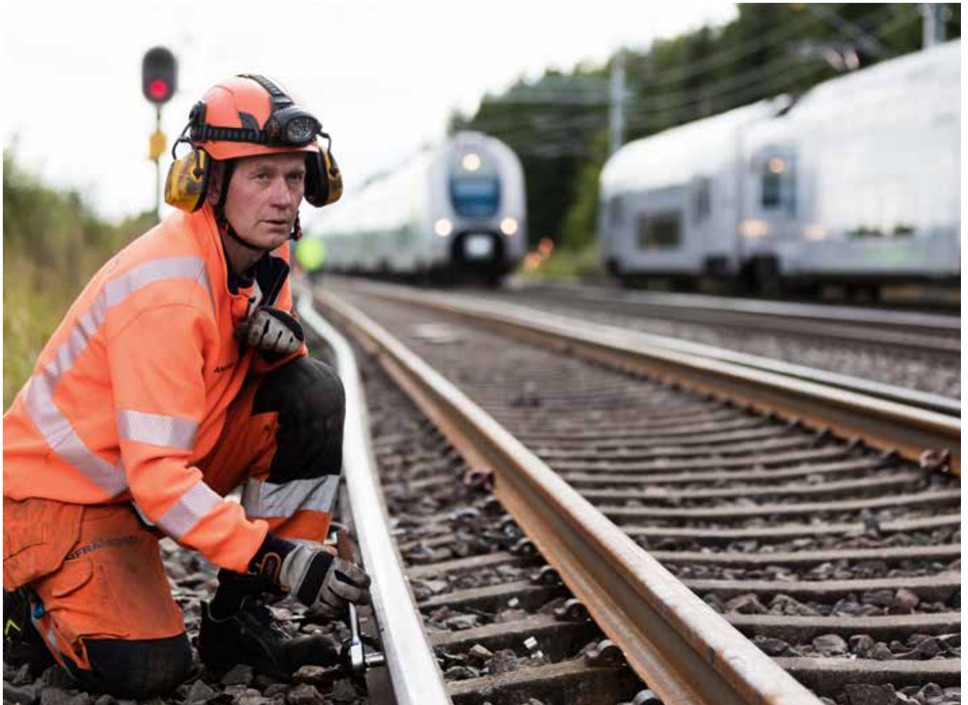
Tekniker i arbete vid dubbelspår i Regumatorp, Västergötland.
