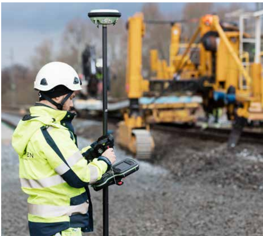
GPS-mätning av växeläge vid partiellt dubbelspår i Kristianstad, Skåne.
